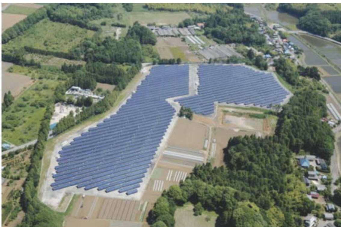
春日キャピタル五十土東太陽光発電所・春日キャピタル五十土西太陽光発電所
