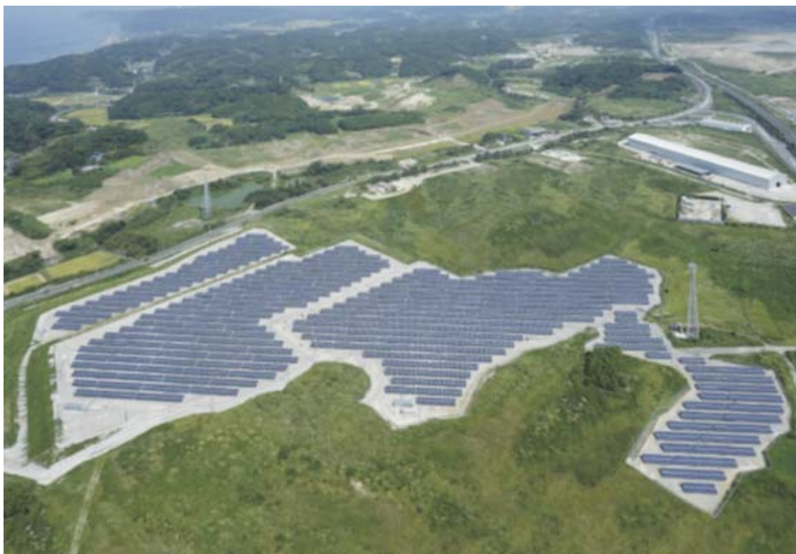
春日キャピタル富津東太陽光発電所・春日キャピタル富津西太陽光発電所
