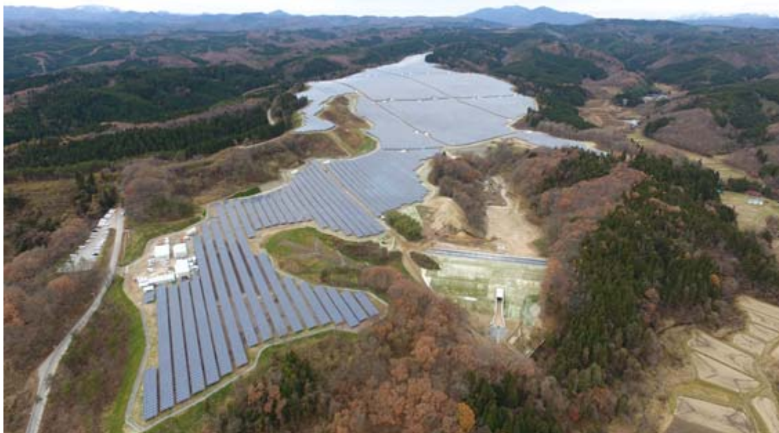
パシフィコ・エナジー 古川メガソーラー発電所
